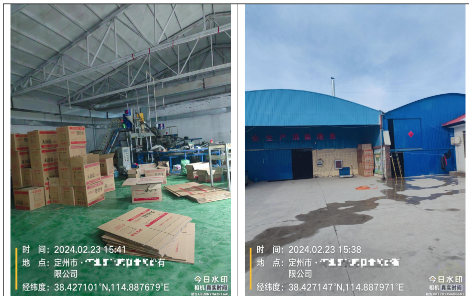
厂区现有车间现状照片
