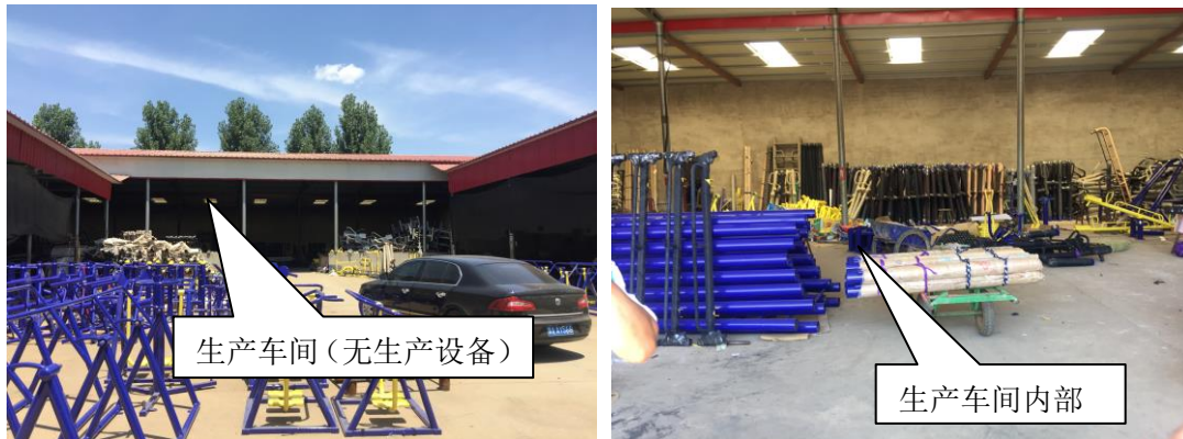
图2 厂区现状照片
