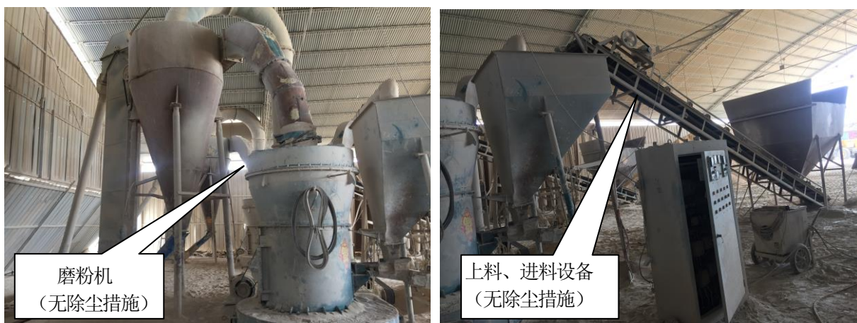
图 2 厂区现状照片
