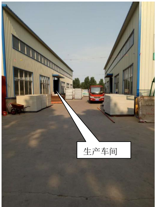
图 2 厂区现状照片
