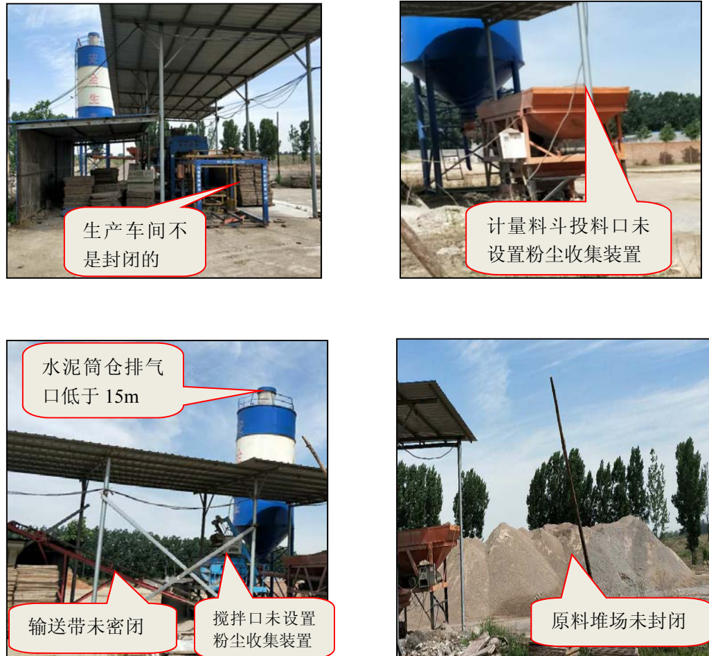
图 3 厂区生产现状
