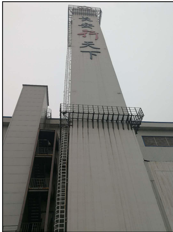
图 3.13 B区涂装车间喷漆废气治理设施及排气筒
