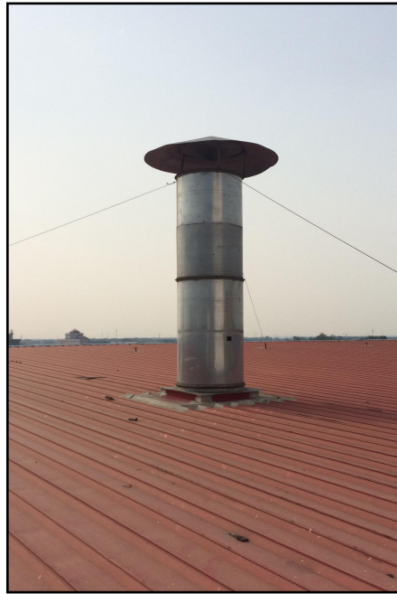
图 3.11 B 区涂装车间 PVC 底涂废气排气筒
