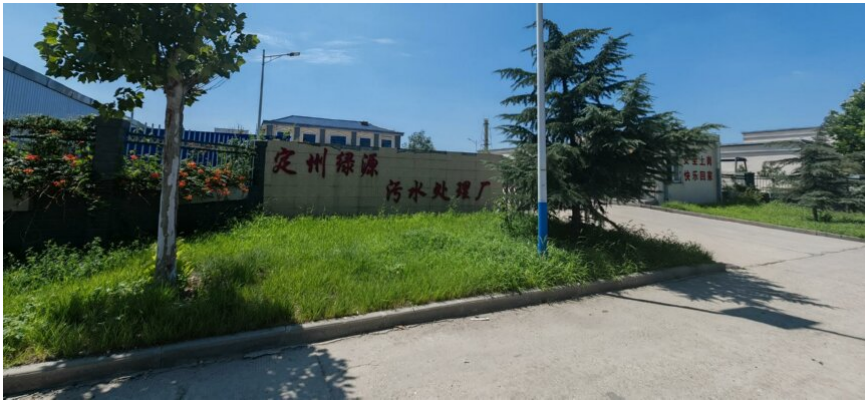
图 3-1-5 定州绿源污水处理厂现状图
